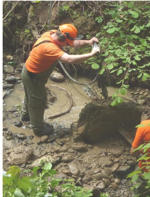
Da der Einsatz von „Habeggern“ zu viel Zeit kostete, wurde ein Feuerwehrfahrzeug mit einer Seilwinde eingesetzt. Nachdem ein T-Eisen samt Fundament aus dem Bachbett gerissen war, wurde das Betonfundament mit dem Abbauhammer zertrümmert.
