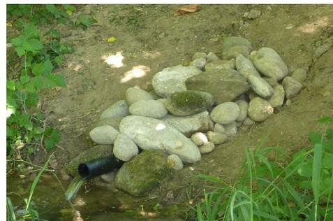
Während die alte Leitung vorher um das Brückeprofil (siehe Foto oben rechts) und in einem Auf und Ab zum Amphibienweiher führte, verläuft die neue Speiseleitung mit linearem Gefälle unterirdisch vom Schiessstand zum Weiher und funktioniert einwandfrei (Fotos links und unten rechts)
